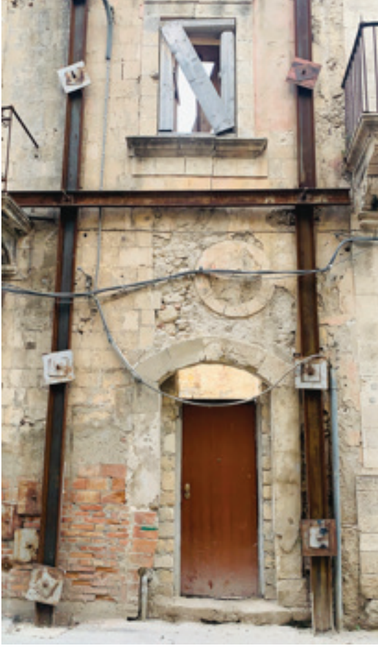
Bina Dış Cephe Desteklenmesi, Ortigia
