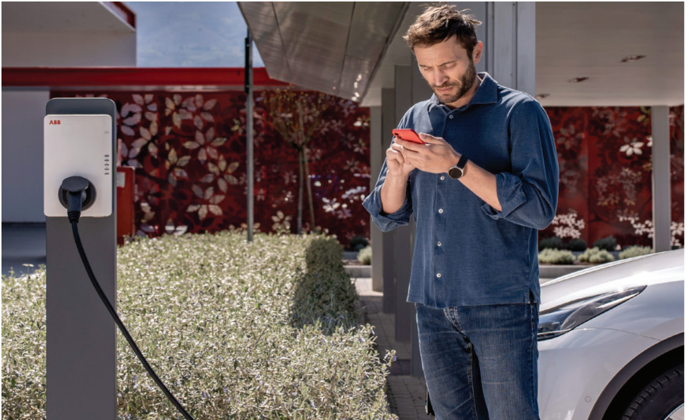
Şekil-7: Elektrikli araç şarj istasyonu
