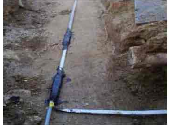
Şekil 1: Çubuk elektrot ile topraklama tesisi Prizin İncelenmesi
